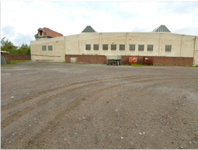
Lager-Freifläche (Teilgrundstück) in Bad Oeynhausen-Rehme
