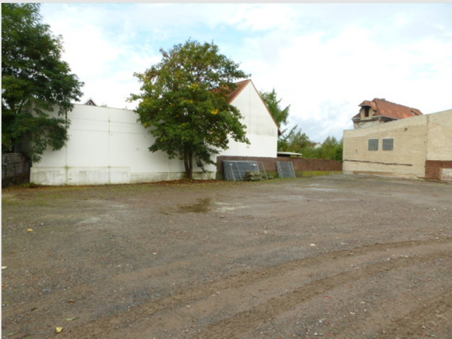
Lager-Freifläche (Teilgrundstück) in Bad Oeynhausen-Rehme
